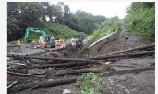
中央自動車道 災害復旧箇所調査状況
